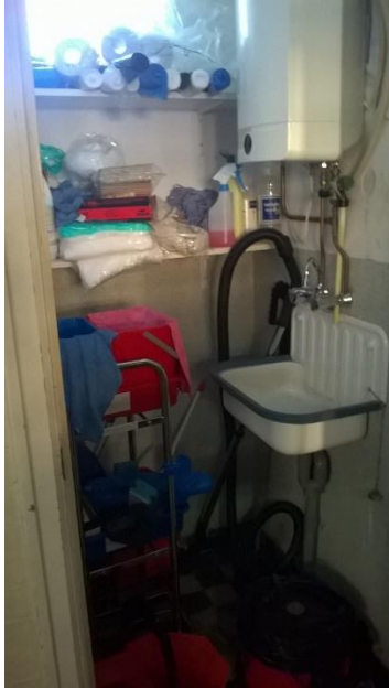
Foto 3: schoonmaak hok, welke niet afgesloten is.
